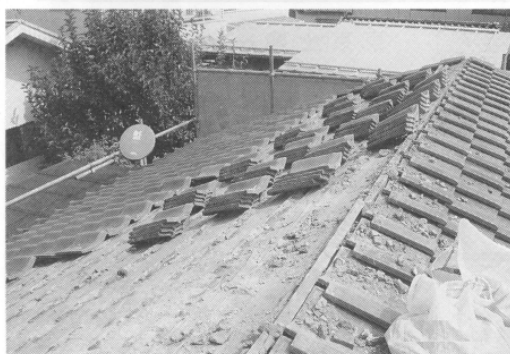
重い瓦を降ろして (下の写真へ)
