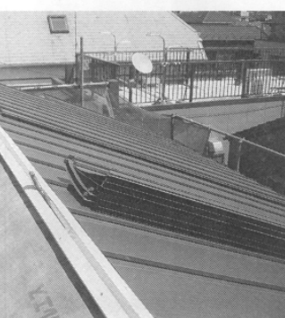
二ウム鋼板張りに替え軽量化
